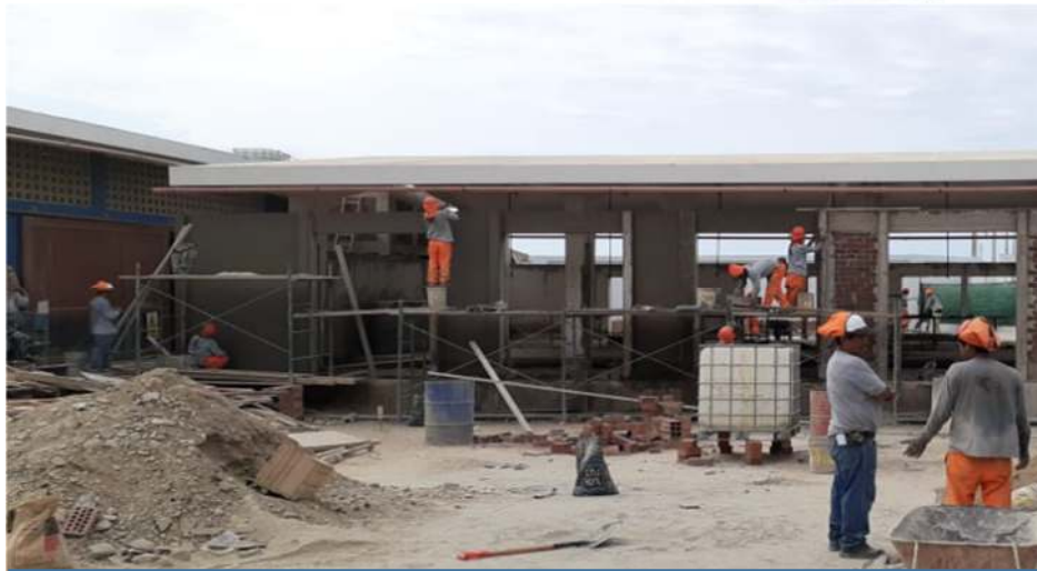
Tarrajeo de muro para exterior de zona de tareas previas.
