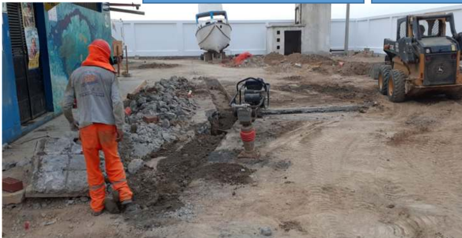
Relleno y Compactado de zanja para red de desagüe
