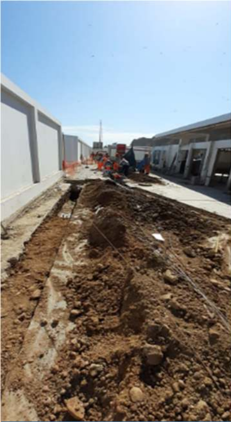
Excavación de zanja eléctrica y zanja de tubería pluvial
