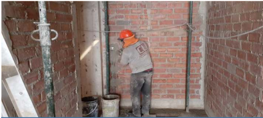
Colocación de puntos eléctricos en área de desinfección
