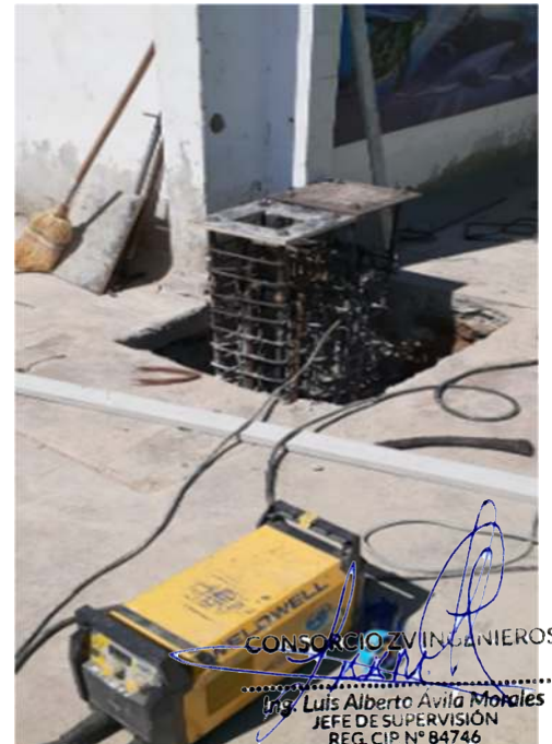
Colocado de acero en pedestales área de tareas previas
