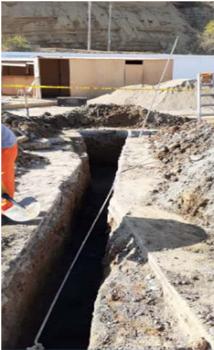
Ecavacion de Zanja para tendido de tuberías de desagüe
