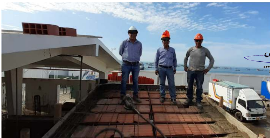
Encofrado, colocado de acero (vigas, temperatura, viguetas), vaciado de Losa Aligerada en zona de residuos solidos
