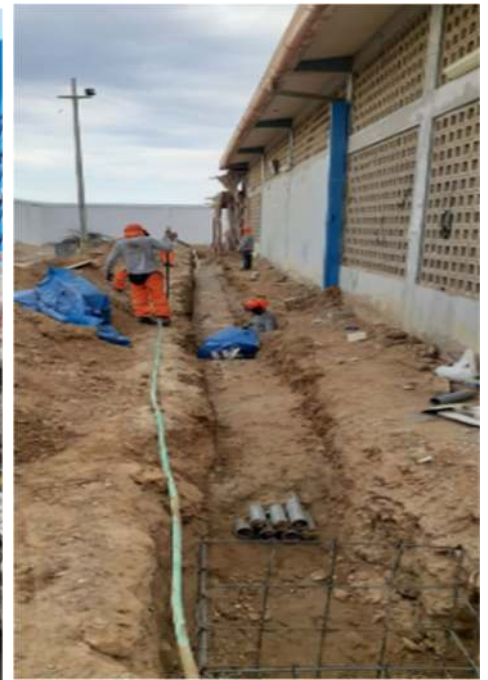
Tendido de tuberías para red eléctrica en zanja de 0.80 x 060
