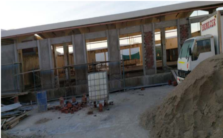
Tarrajeo de muro de tareas previas
