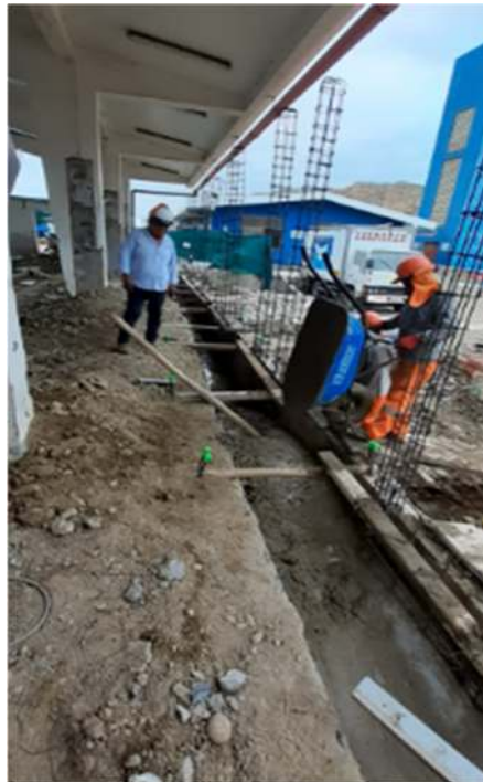
Cimiento corrido e zona de tareas previas
