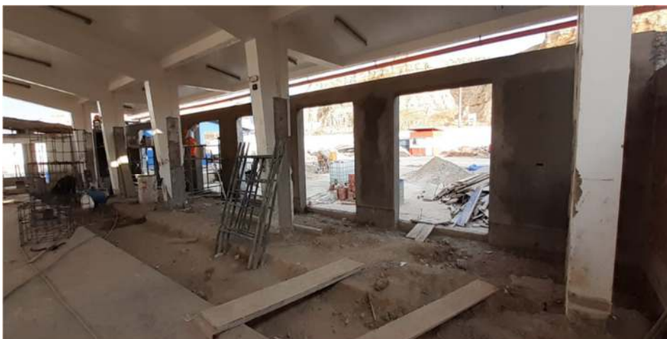
Tarrajeo interior de muro del área de tareas previas
