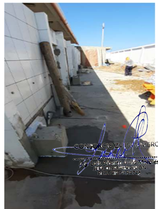
Vaciado losa alrededor de pedestales área de tareas previas
