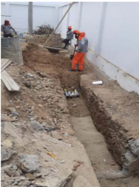
Excavación, Tendido de tuberías en zanja eléctrica de 0.80 x 0.60 parte posterior de la obra (zona de desinfección)
