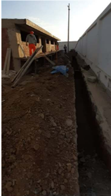
Excavación de zanja eléctrica de 0.80 x 0.60
